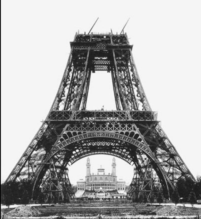
La tour Eiffel en construction (1889)
